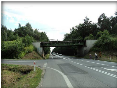
Wiadukt kolejowy w rejonie Pilawy
