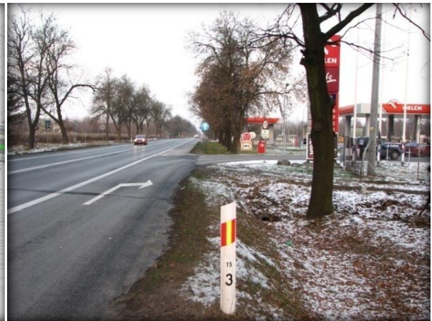
Stacja benzynowa w Woli Duckiej na terenie projektowanego MOP
