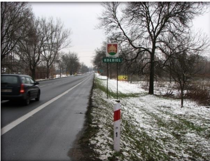
S17 na granicy gminy Kolbiel źródło: inwentaryzacja terenowa
